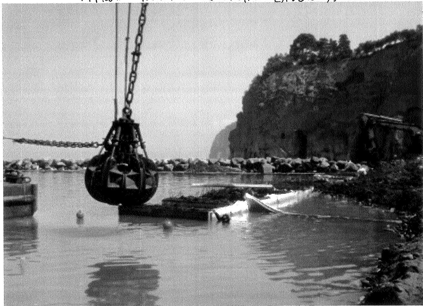
APPRODO MARINA DI CASSANO LAVORI IN CORSO
