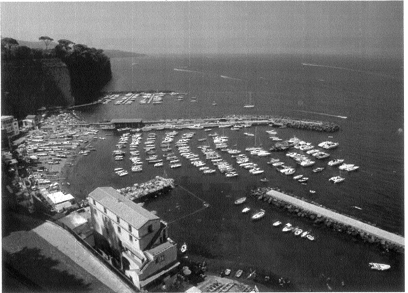
APPRODO MARINA DI CASSANO PRIMA DEI LAVORI
